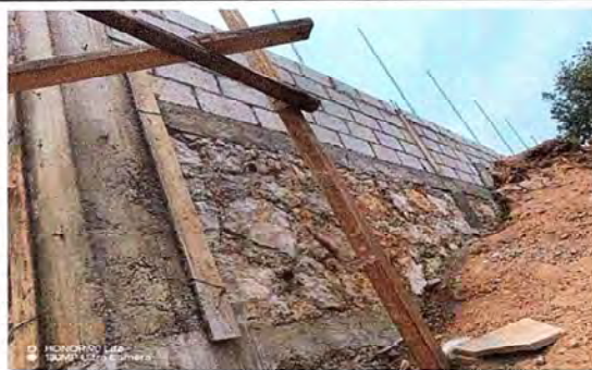
MURO DE CONTENSION DE LA ESQUINA PARTE FRONTAL IZQUIERDA DE LA ESUELA
