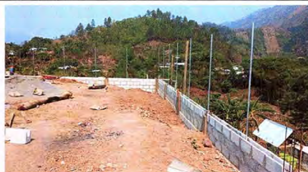
COLOCACIÓN DE BLOCK Y TUBOS QUE SOSTENDRÁ LA ELECTROMALLA
