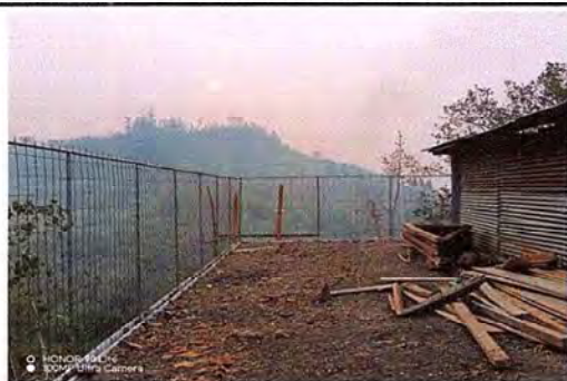
FOTOGRAFIA QUE EVIDENCIA LA COLOCACIÓN DE LA ELECTROMALLA
