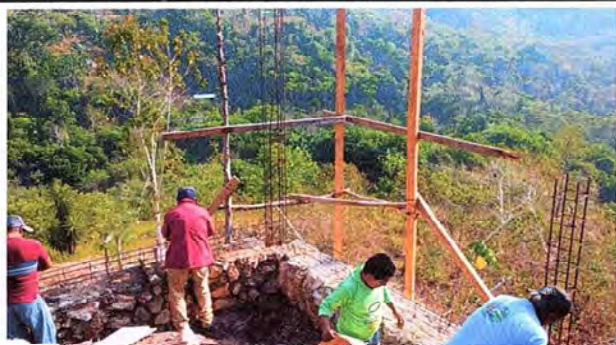
MURO DE CONTENSION DE LA ESQUINA PARTE FRONTAL DERECHA DE LA ESCUELA
