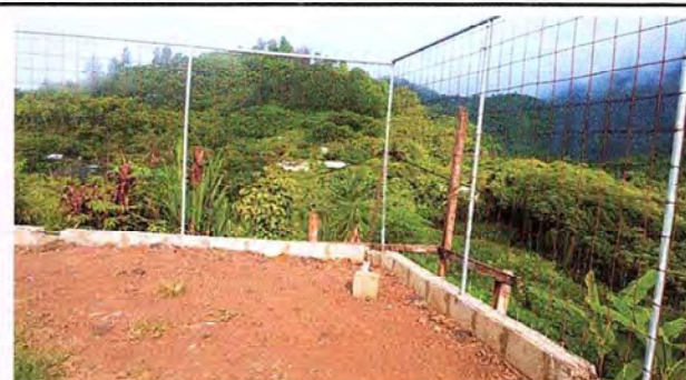
EVIDENCIA DEL LLENADO DEL BLOCK U, PARA ASEGURAR LA ELECTROMALLA
