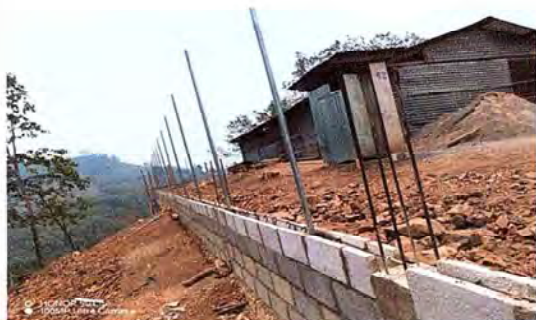
MURO PERIMETRAL DE LA PARTE FRONTAL DE LA ESCUELA
